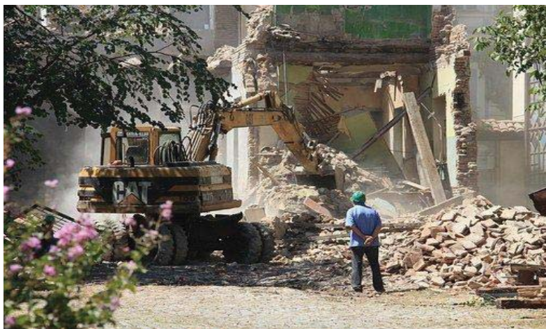
Figura 3.16. Demolarea unei construcții
