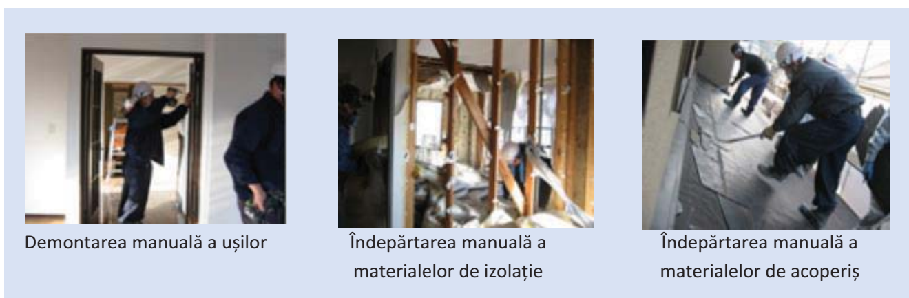
Figura 2.5. Demolare selectiva (adaptat din [20])
