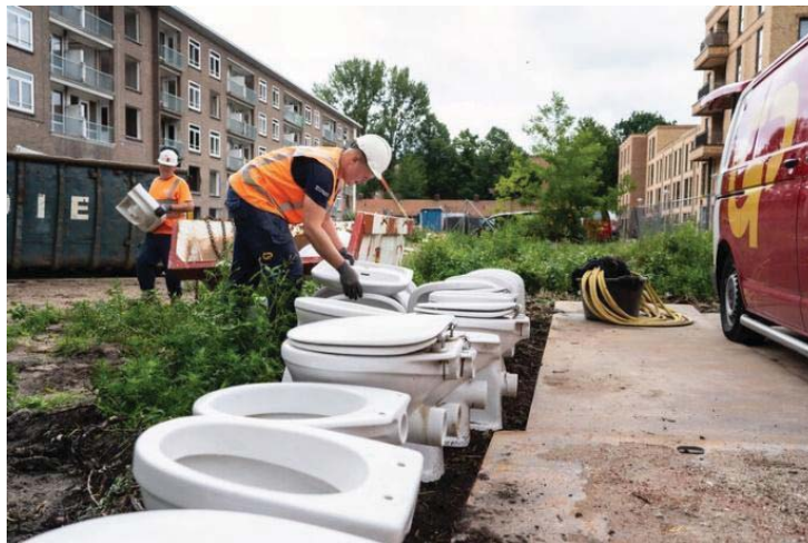
Figura 2.13: Exemplu de proces de demolare (deconstrucție) circulară. Credit foto: Erik Boschman.[8]
