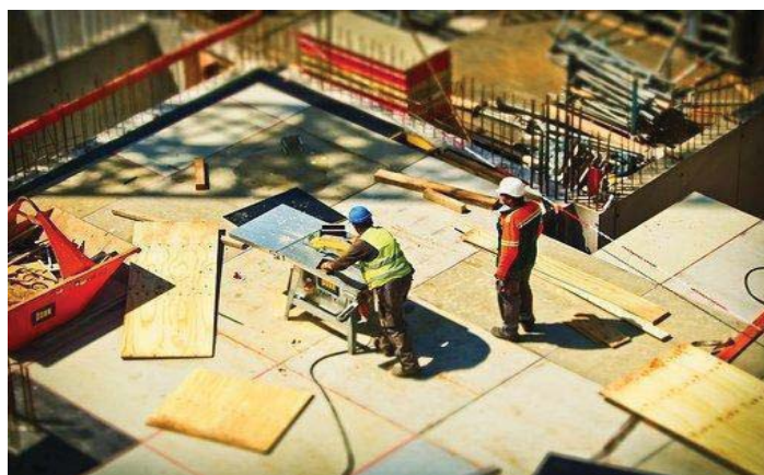
Figura 3.17. Șantier de construcții
