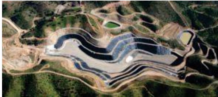
Figure 1.4. Depozit conform de deșeuri. Sursa: Grupotec. www.grupotec.es
