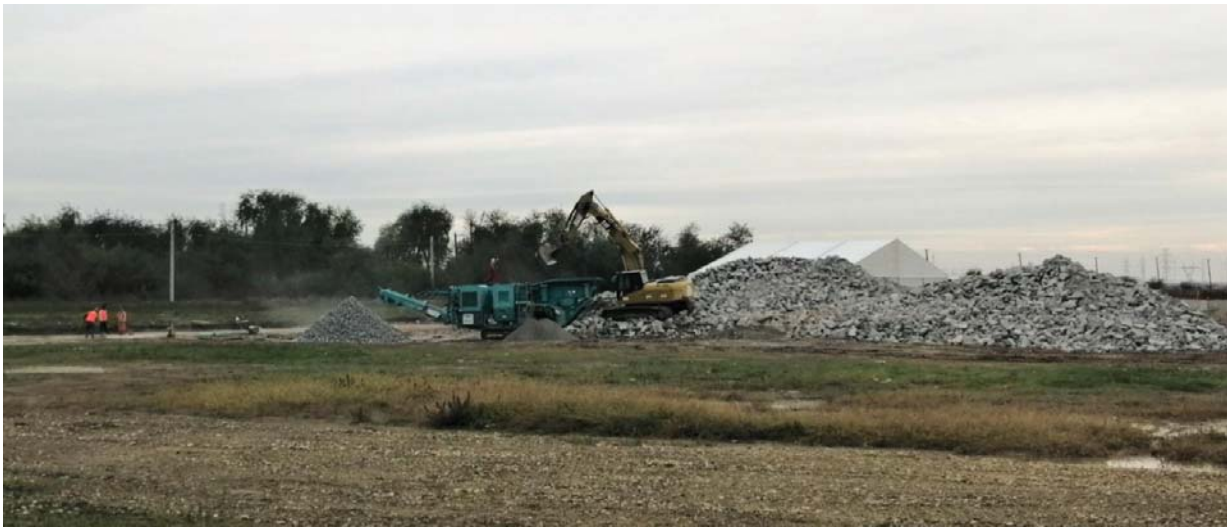
Figura 3.3. Deșeuri de beton prelucrate și folosite ca rambleu pe un șantier din România (credit Rodica Stanescu, 2021)
