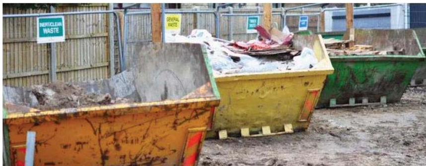
Figura 2.11: Exemplu de separare a deșeurilor din construcții și demolări pe șantier. [2]
