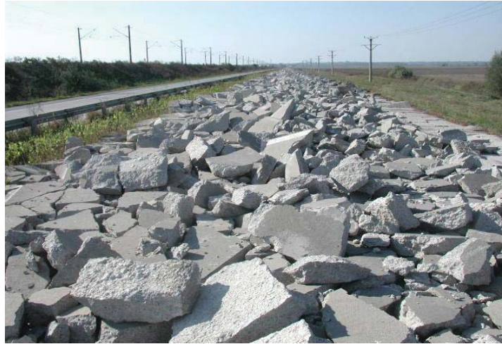
Figura 3.8. Deșeuri de beton rezultate în timpul reabilitării unui tronson de autostradă din beton (credit: Radu Gavrilescu)
